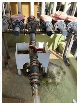
ローリー車による未漏洩残液回収
