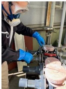
漏洩部位漏れ止め
