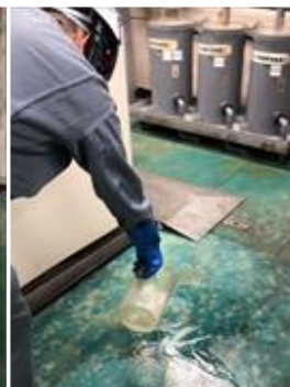
吸収マット準備、漏洩箇所拭き取り・水洗
